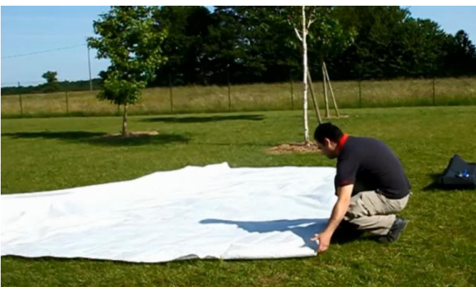
3. Installation du géotextile de protection (il est recommandé de le fixer à l'aide d'agrafes pour faciliter le déroulage de la citerne)
