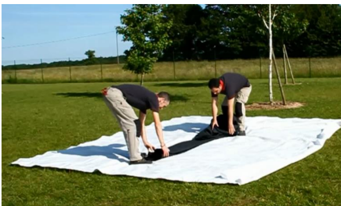
4. Déroulement de la citerne dans le sens de la longueur, puis déroulement dans le sens de la largeur
