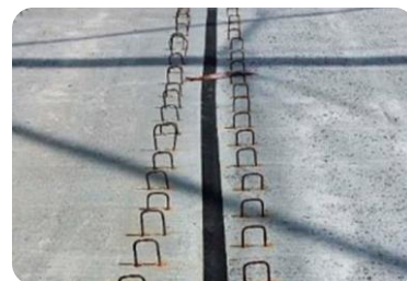
Étanchéité entre joints de prédalles
