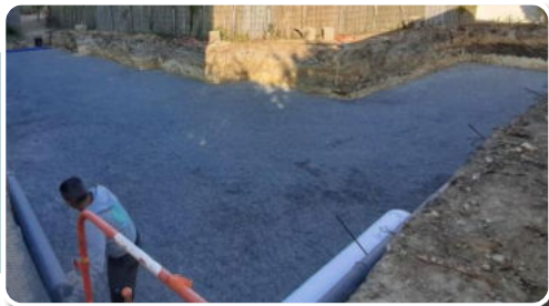
1 Préparer le terrassement
