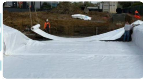
2 Poser le géotextile de protection extérieur
