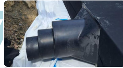
7 Découper et positionner les collerettes de sortie
