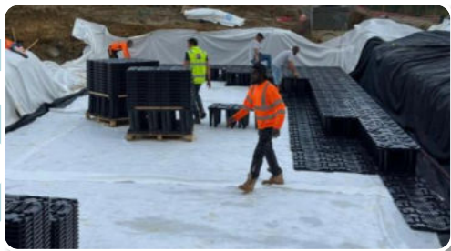
5 Poser le géotextile intérieur puis installer les casiers
