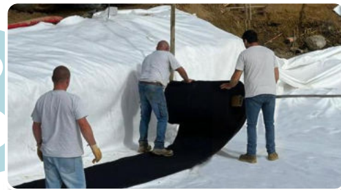
3 Dérouler la géomembrane EPDM
