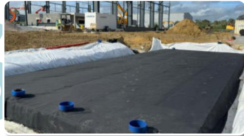
6 Rabattre la géomembrane EPDM sur les casiers
