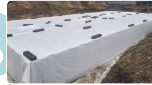
8 Rabattre le géotextile de protection intérieur sur la membrane EPDM
