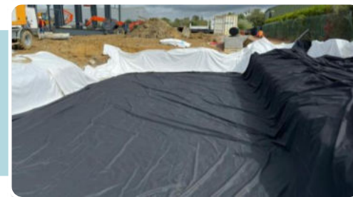
4 Déplier la géomembrane EPDM
