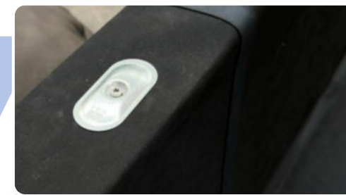
7 Fixer mécaniquement en tête de relevés
