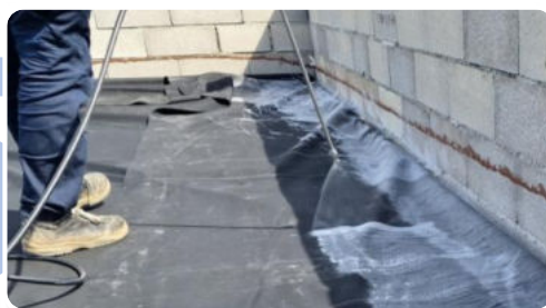
5 Encoller les relevés à la colle pulvérisable puis maroufler
