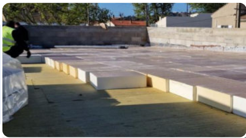
1 Placer l'isolant*
