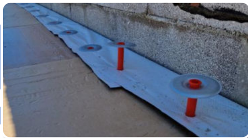
2 Tracer le calepinage puis mettre en place les fixations
