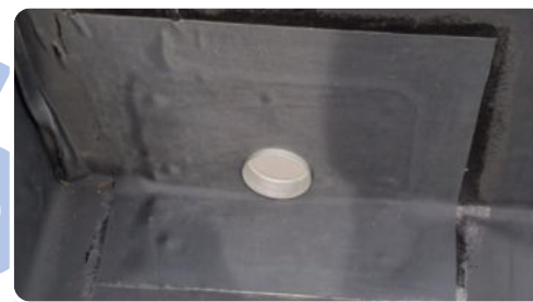
6 Fixer les entrées d'eaux pluviales
