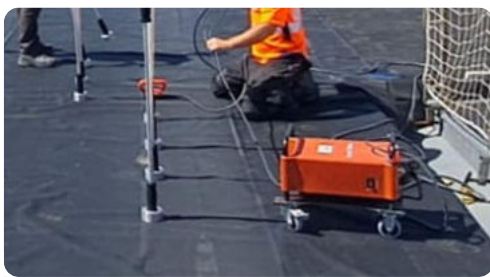
4 Calibrer la machine puis souder par induction
