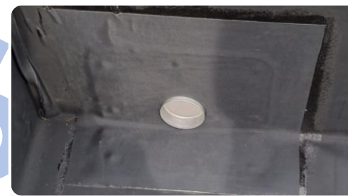
Fixer les entrées d'eaux pluviales
