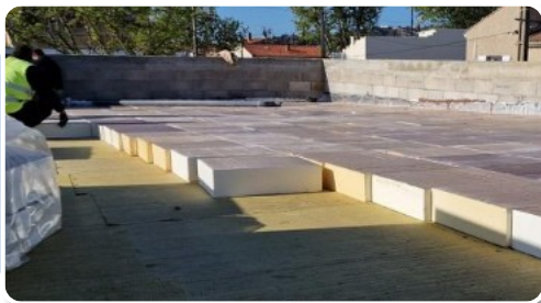
Placer l'isolant*
