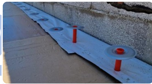
Tracer le calepinage puis mettre en place les fixations
