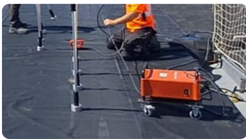
Calibrer la machine puis souder par induction
