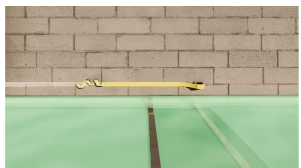
5. Poser l'adhésif double-face sur le pied du mur et installer les relevés de film anti-radon en prenant soin de bien maroufler pour éviter la formation de pli.
