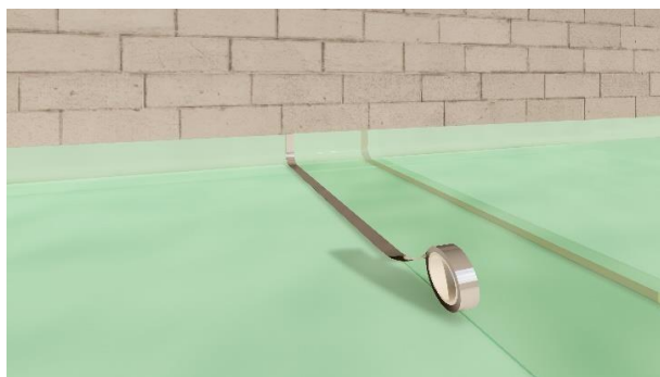
4. Poser l'adhésif raccord* afin de bloquer et sécuriser le bord du recouvrement, puis maroufler en évitant la formation de pli.
