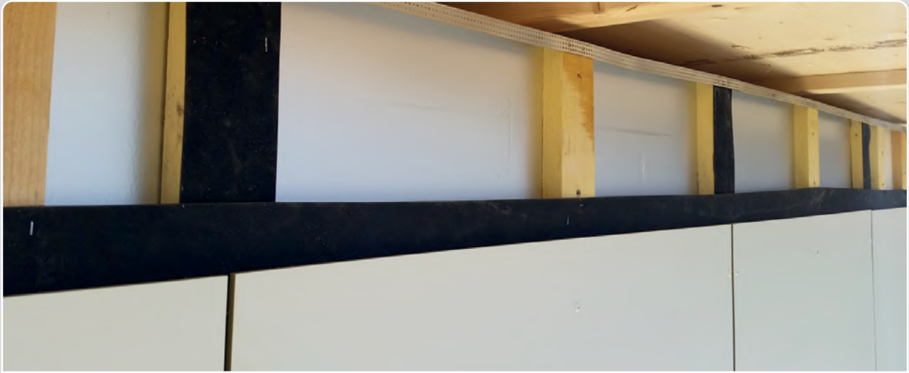
Bande de protection pour ossature bois sous bardage rapporté
