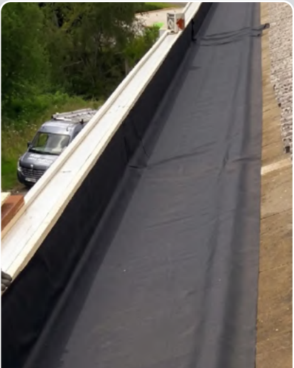
Étanchéité et/ou réparation de chéneau
