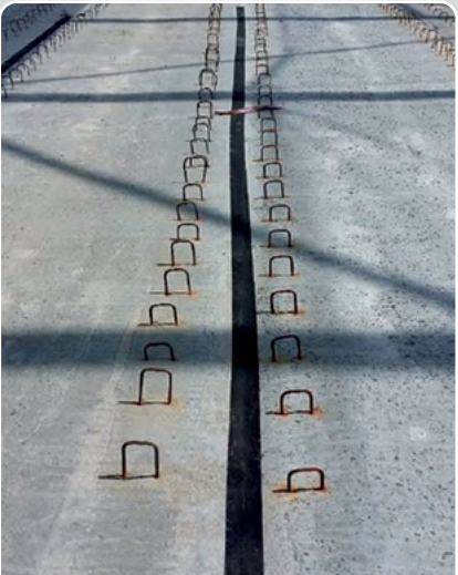
Étanchéité entre joints de prédalles
