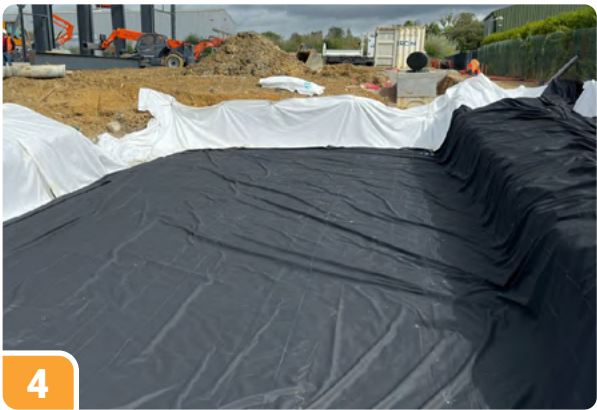
Déplier la géomembrane EPDM
