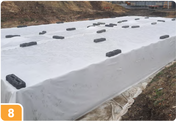
Rabattre le géotextile de protection intérieur sur la membrane EPDM
