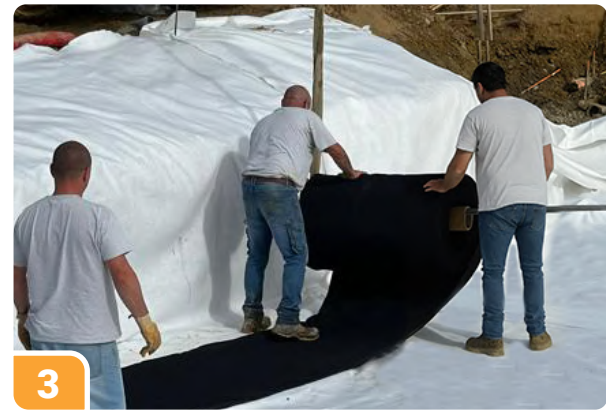
Dérouler la géomembrane EPDM
