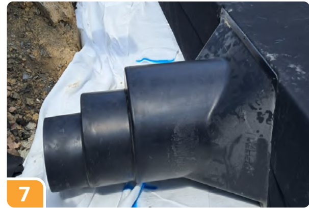
Découper et positionner les collerettes de sortie
