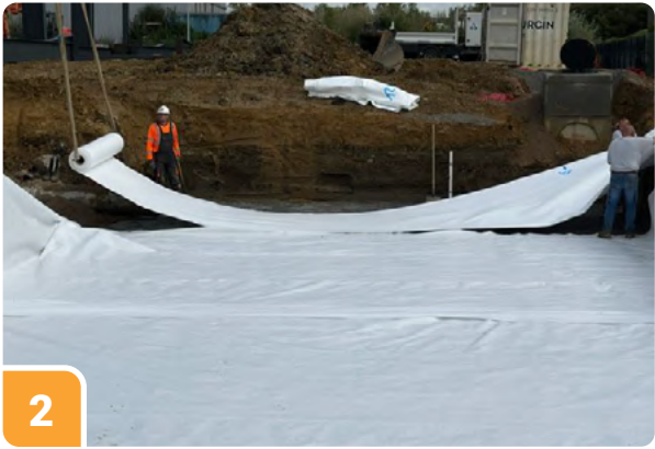
Poser le géotextile de protection extérieur
