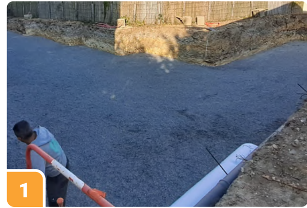
Préparer le terrassement
