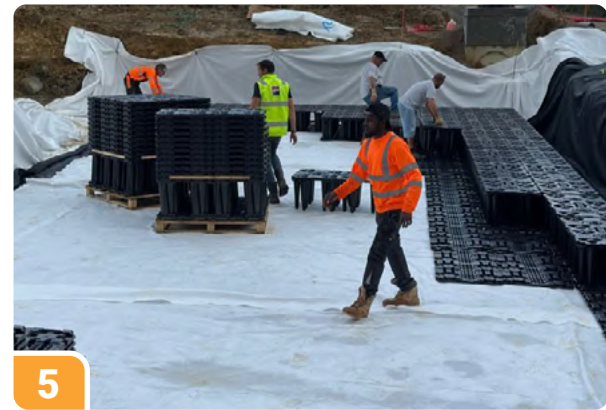
Poser le géotextile intérieur puis installer les casiers
