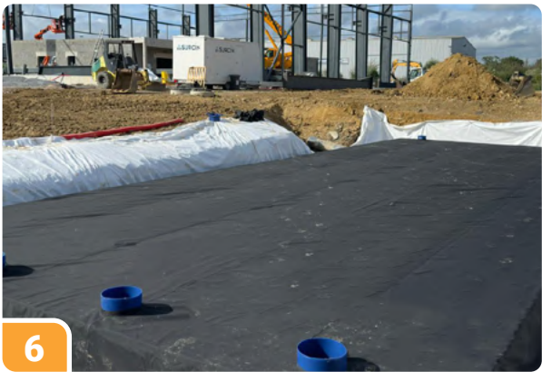
Rabattre la géomembrane EPDM sur les casiers
