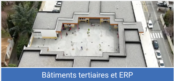
Bâtiments tertiaires et ERP
