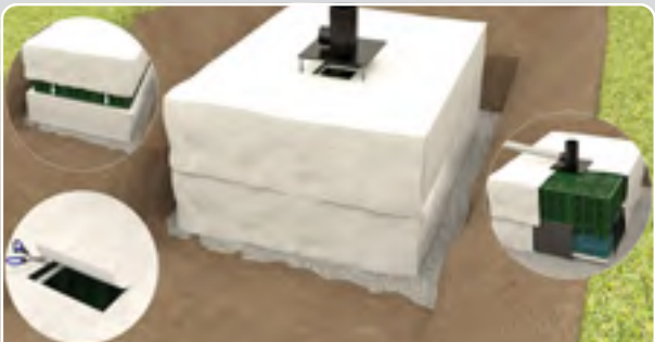
Positionner le géotextile de protection sur le second niveau et la réhausse
