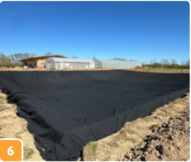
4 Dépliage de la géomembrane
