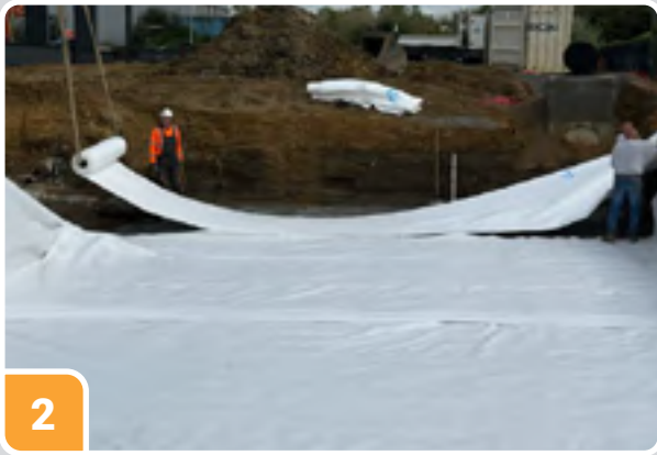
2 Poser le géotextile de protection extérieur
