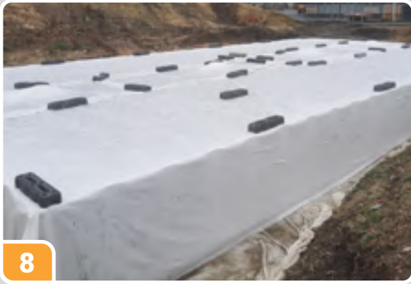
8 Rabattre le géotextile de protection intérieur sur la membrane EPDM
