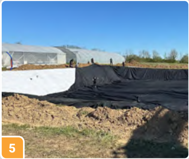
3 Positionnement et déroulement de la géomembrane en haut de talus
