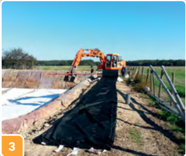
4 Dépliage de la géomembrane
