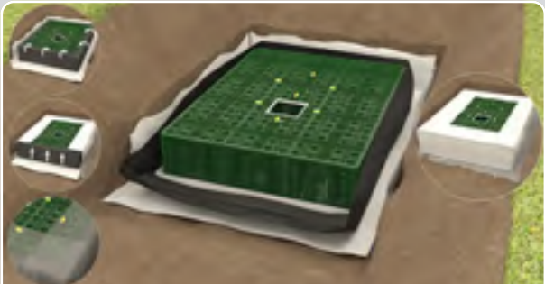
Finaliser le 1er niveau, clipser les connecteurs et rabattre le géotextile
