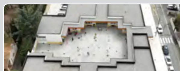
Bâtiments tertiaires et ERP
