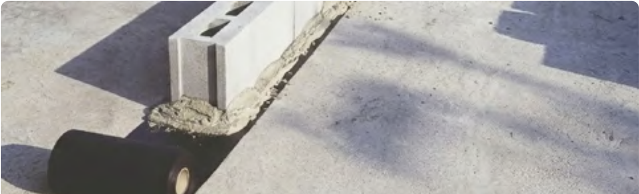
Application d'une bande d'arase pour assurer l'étanchéité contre les remontées d'humidité
