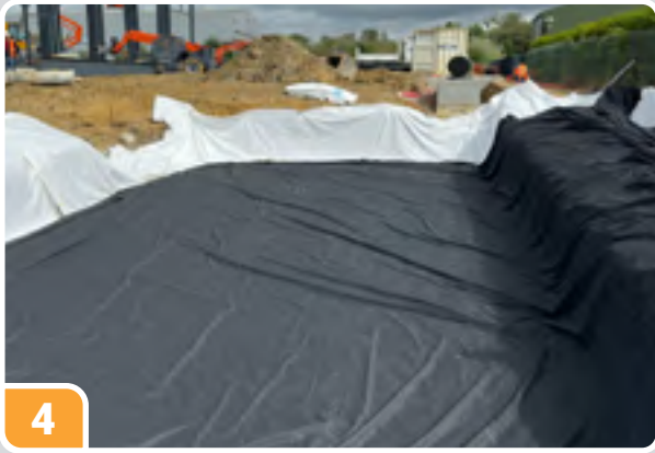
4 Déplier la géomembrane EPDM
