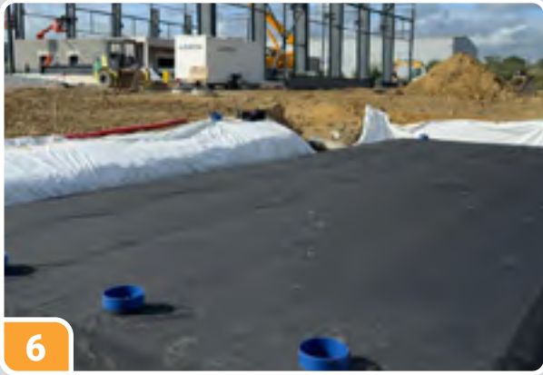
6 Rabattre la géomembrane EPDM sur les casiers
