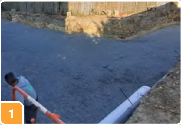
1 Préparer le terrassement
