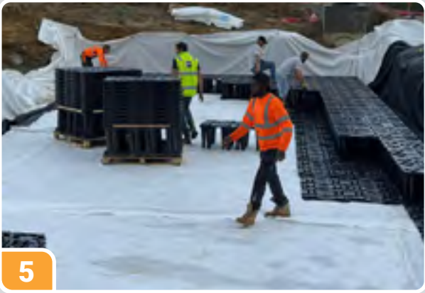
5 Poser le géotextile intérieur puis installer les casiers
