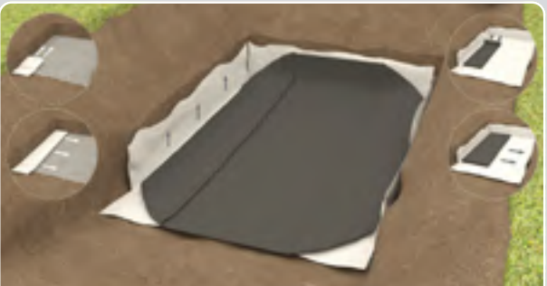
Poser le géotextile et la géomembrane EPDM 3D
