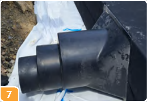
7 Découper et positionner les collerettes de sortie
