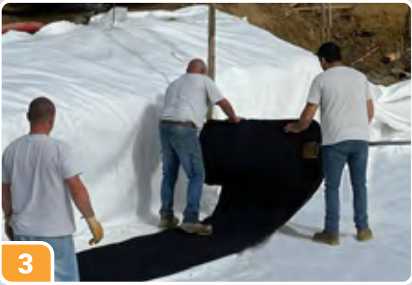
3 Dérouler la géomembrane EPDM
